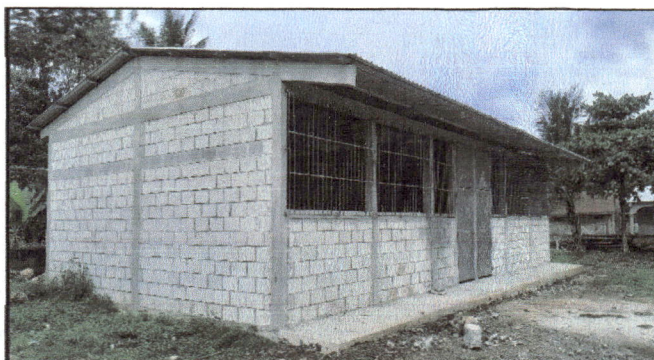
Foto 4: En vista que las balcones de frente ya se instalo.
