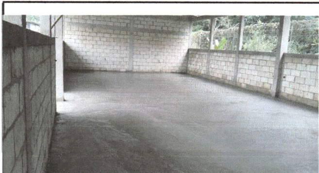
Foto1: Ya fue dundido el piso terminando de hacer pulido.
