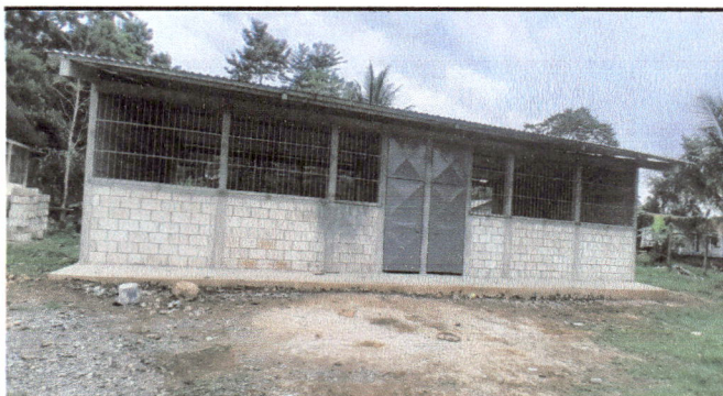
Foto 3: Se coloco las puertas de las dos aulas.
